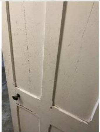
Morgue 4 – Original Timber Door
