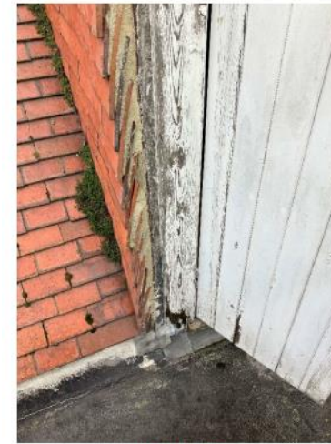
Roof 5 – Door frame
